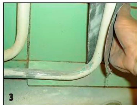
После удаления отслоений краски поверхность следует тщательно обработать шлифовальной шкуркой.
