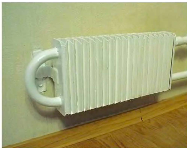
И батарея, и трубы после покраски стали как новые — приятно посмотреть.
