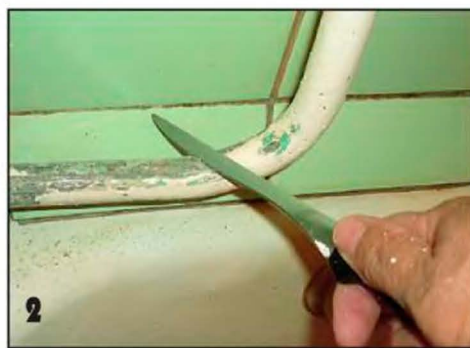
Все неровности старого покрытия и отслоившуюся краску счищают. Для этого можно воспользоваться обычным ножом.
